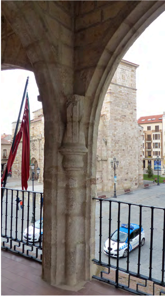
Figura 3. El Ayuntamiento viejo. Arranque de la desaparecida bóveda de crucería de la torrecilla oriental de la fachada.
